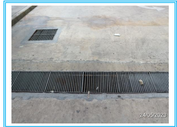
รูปที่ 2.3.1 ระบบระบายน้ำฝน
