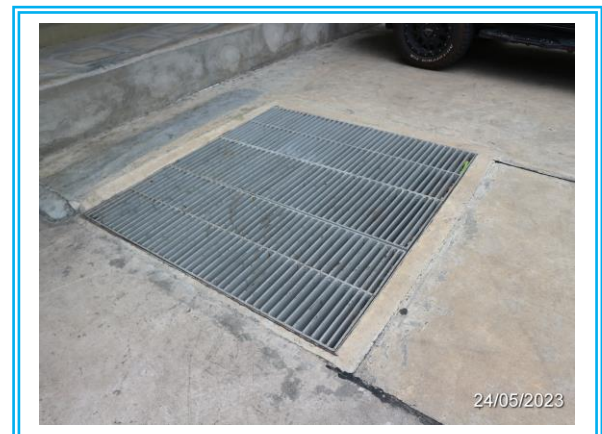
รูปที่ 2.3.4 บ่อพักน้ำสุดท้ายก่อนออกนอกโครงการ
