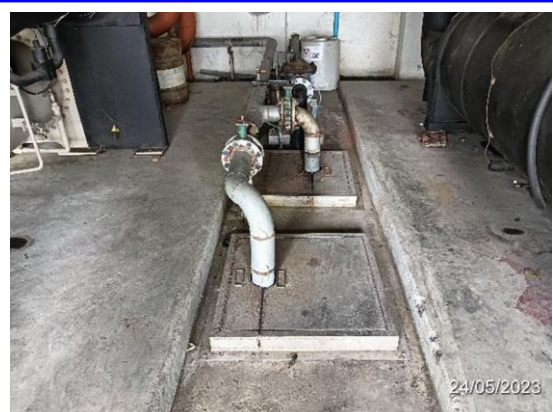
รูปที่ 3-14 ฝาทังเก็บน้ำใต้ดิน
