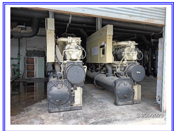
รูปที่ 3-26 ระบบระบายความร้อนด้วยน้ำ แบบสกรู
