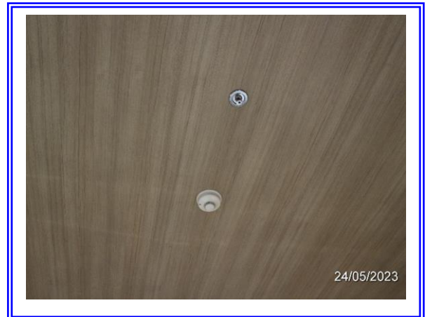
รูปที่ 3-29 เครื่องตรวจจับควัน
