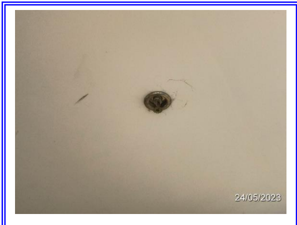
รูปที่ 3-34 ระบบหัวจ่ายน้ำดับเพลิงอัตโนมัติ
