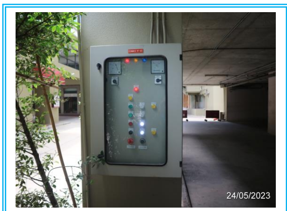
รูปที่ 2.3.8 แผงควบคุมระบบสัญญาณแจ้งเหตุเพลิงไหม้
