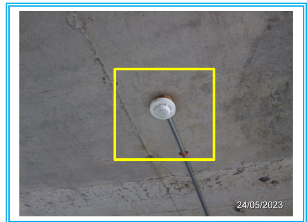
รูปที่ 2.3.11 เครื่องตรวจจับความร้อน
