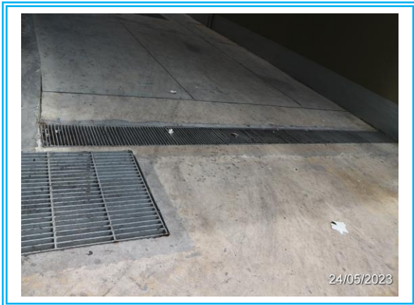
รูปที่ 2.3.1 ระบบระบายน้ำฝน
