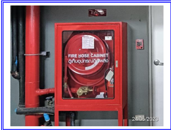
รูปที่ 3-32 ตู้เก็บสายฉีดน้ำดับเพลิงพร้อมอุปกรณ์
